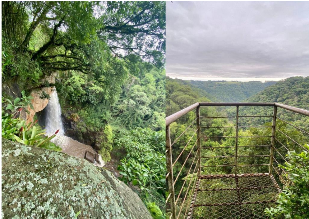
Foto 4: Cascata das Andorinhas vista de cima e a estrutura em ferro
