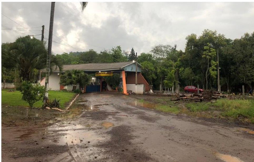
Foto 9: Entrada do empreendimento Águas do Prado.
